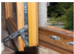
Renvoi d'angle en partie basse, sortie de tringle sur traverse haute du semi-fixe
